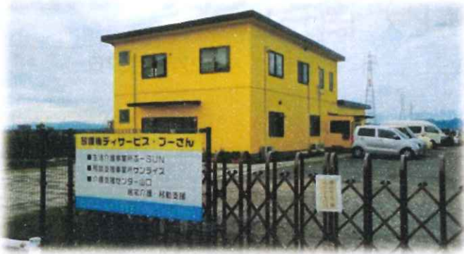
プーさん建物外観
